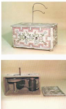
図5：第3巻24ページ。平賀源内作エレキテル通信総合博物館蔵静電式医用電気具（摩擦起電機）。 ハンドルを回して筐の中の瓶にたくわえ、筐上部に突出した銅線から放電し治療者に帯電させた。「諸痛のある病人の痛所より火をとる器なり」と文献にある。平賀源内は長崎で破損したエレキテルを貰い、1776年江戸で修理・復元した。
